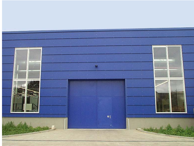
S4 Stahltor mit Schlupftür für ein Lagergebäude.
