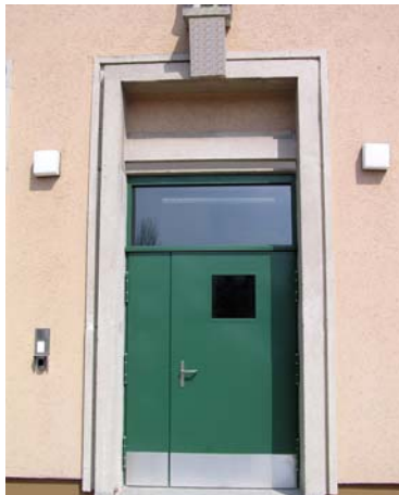
1-flg. S4 Tür mit Lüftungslamellen und Seitenteilen, mit Antipanikfunktion, einbruchhemmend in RC4, für einen Flughafen.
