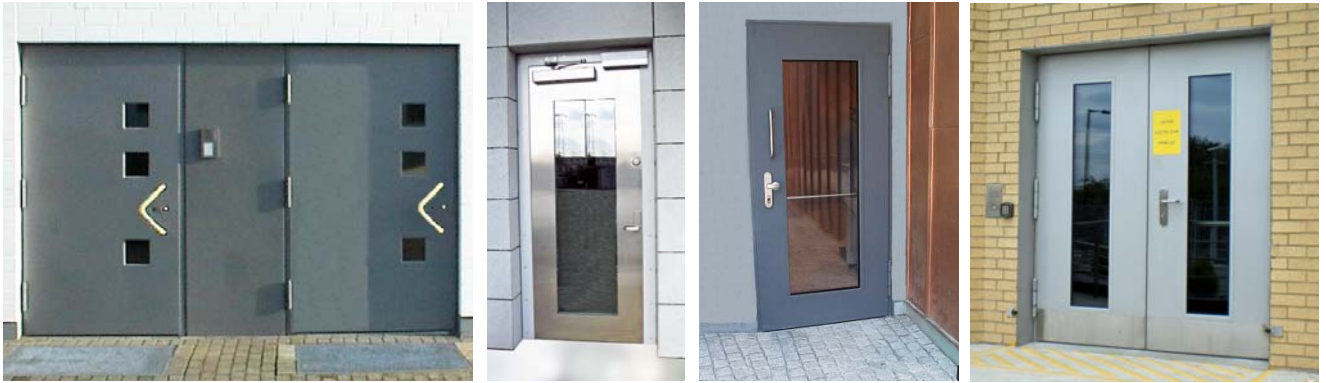
Fotos von links nach rechts: Zwei 1-flgl verglaste S4 Außentüren einer JVA. 1-flg. mit Edelstahl beplante S4 Außentür einer Radiostation. 1-flg. verglaste S4 Außentür einer Polizeistation, 2 flg. verglaste sprenghemmende Außentür einer Bahnstation.
